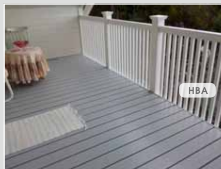
Terrassegulv lagt på veranda. Her med kantlist montert mot rekkverket.
